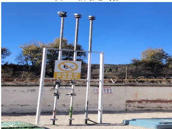
图 13 油罐通气管
