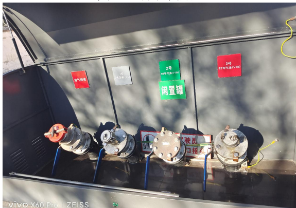
图 13 油罐通气管
