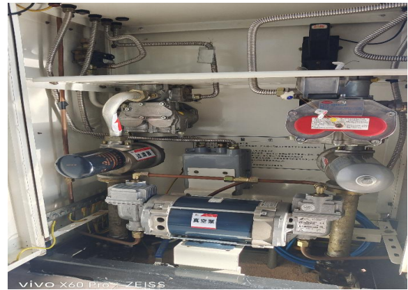
图 6 汽油加油机内部
