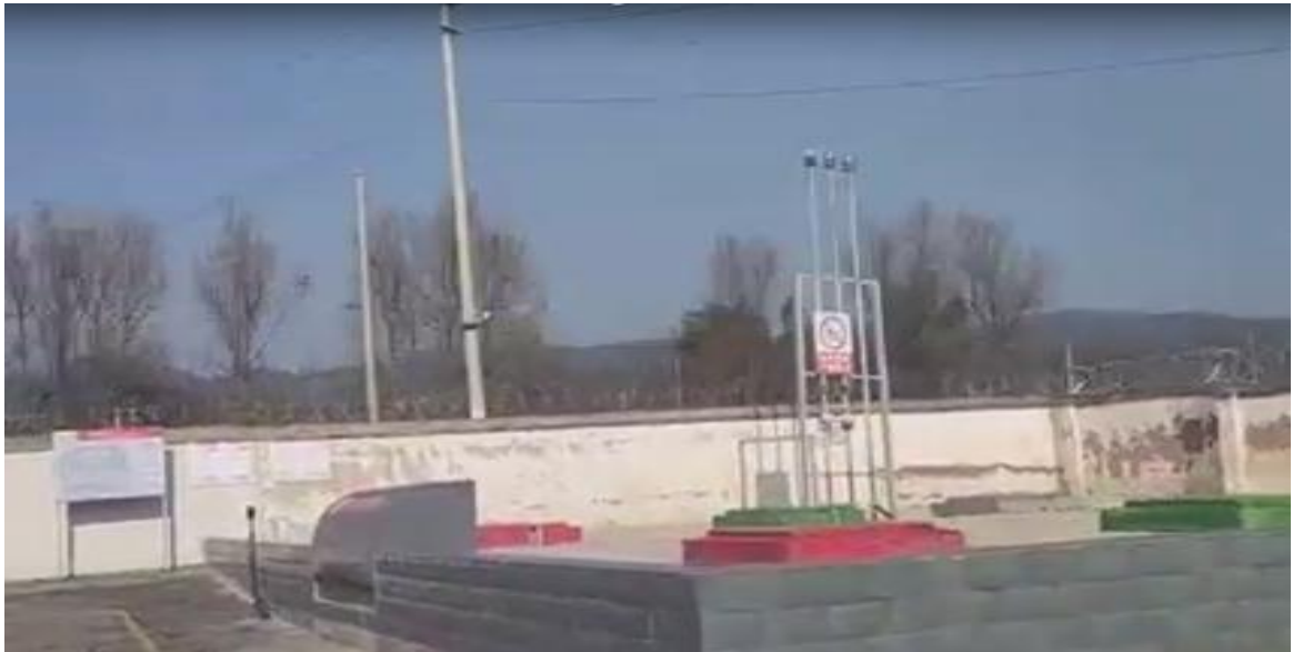
图 4 加油站储罐区
