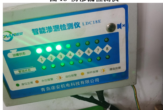
图 18 防渗漏检测仪
